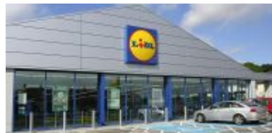
Το πρώτο κατάστημα της Lidl Ελλάς με σταθμό φόρτισης
